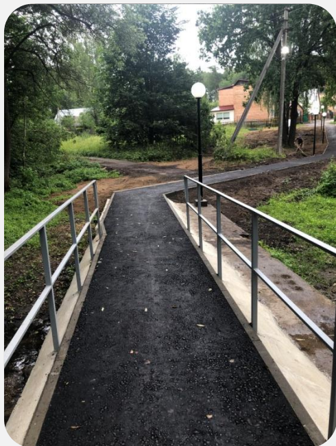
с. Льва Толстого устройство тротуара
