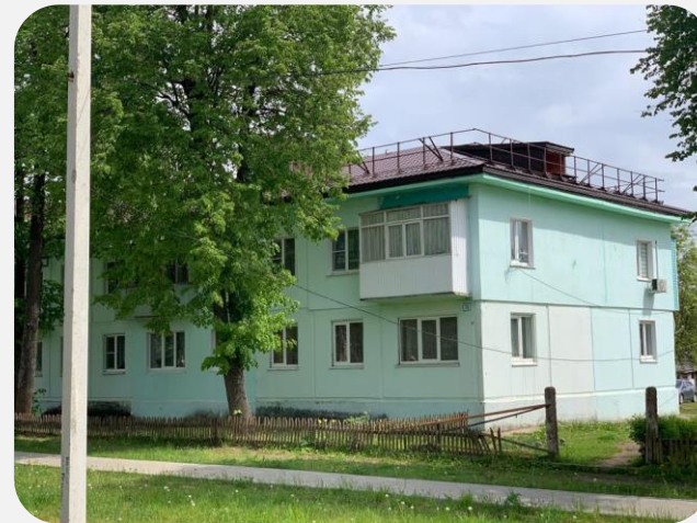
д. Редькино, д. 10 (ремонт крыши)
