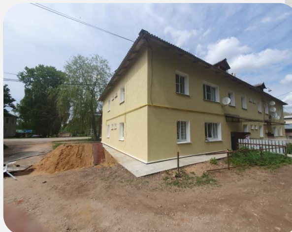
п. Полотняный Завод, ул. Горняк, д.10, Фасад и отмостка
