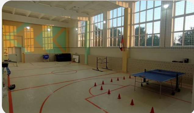
Ремонт спортивного зала МКОУ «Чкаловская СОШ»
