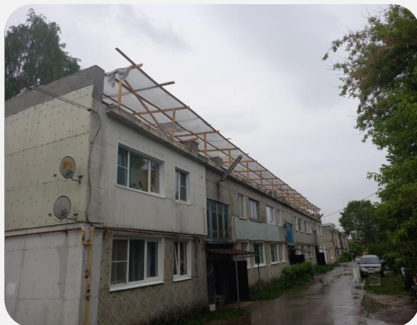
Товарково, ул.Дзержинского, д.6, ремонт крыши
