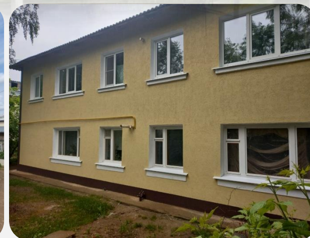
г. Кондрово, ул. Интернациональная д.7 (ремонт фасада)
