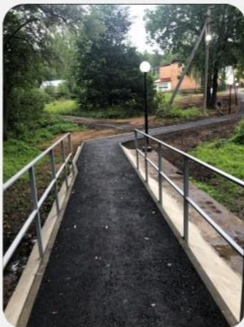
с. Льва Толстого устройство тротуара
