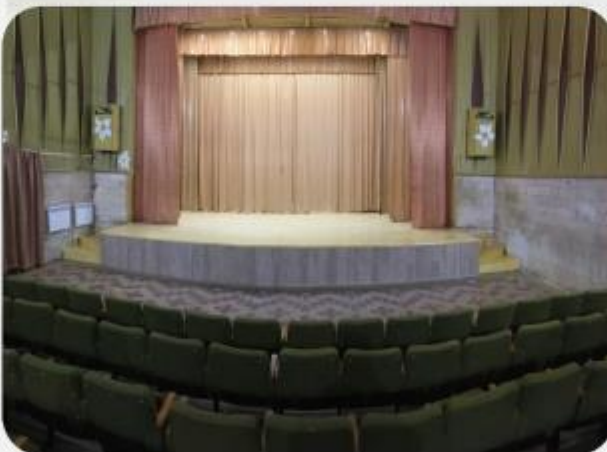
д. Карцово , ремонт Дома культуры
