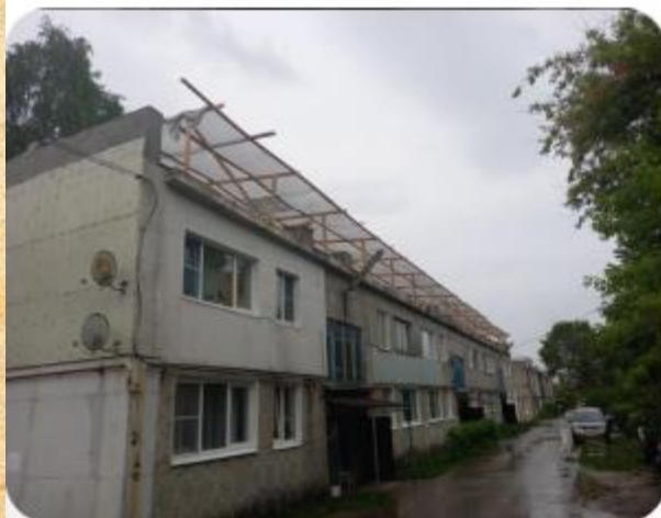
Товарково, ул.Дзержинского, д.6, ремонт крыши
