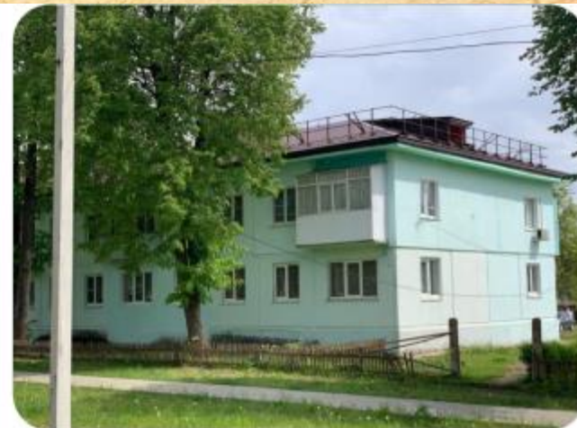
д. Редькино, д. 10 (ремонт крыши)
