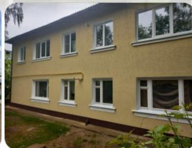
г. Кондрово, ул. Интернациональная д.7 (ремонт фасада)
