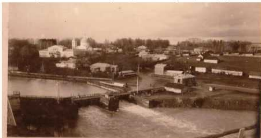
Фото 1. Вид дома в застройке левого берега р. Шани. Фото нач. XX в. из архива Районного краеведческого музея (г. Кондрово)
