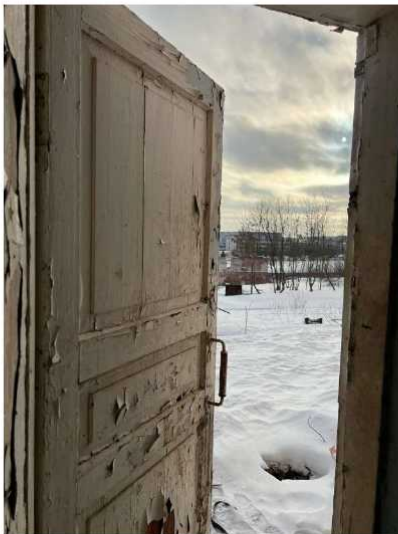
Фото 48. Помещение цокольного этажа главного объема. Фрагмент сохранившегося дверного заполнения.
