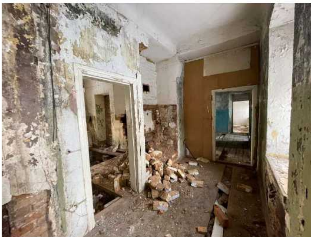
Фото 69. Помещение первого этажа главного объема. Наблюдаются утраты отделочных и штукатурного слоев, обрушение фрагмента кирпичной кладки стен, следы намокания, биопоражений и загрязнения, утраты дверных заполнений, оголение и деструкция кирпичной кладки.
