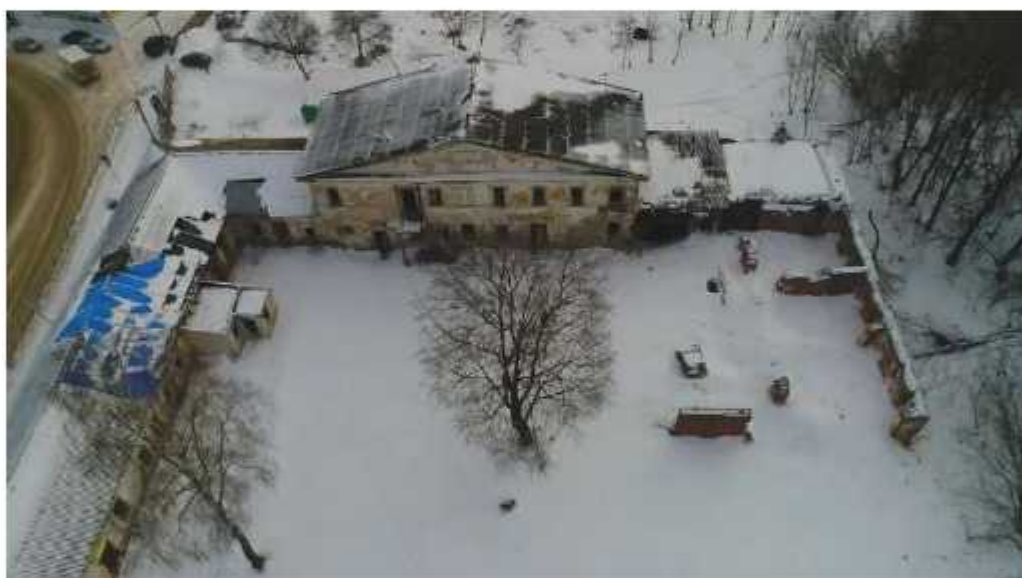
Фото №2. Общий вид сверху.
