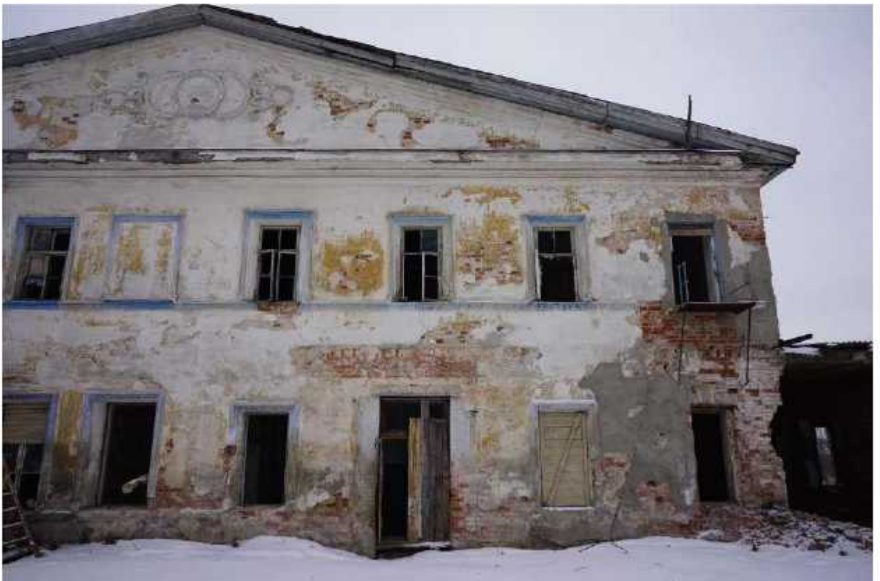
Фото 37. Фрагмент северного фасада (центральный объем). Общее состояние.
