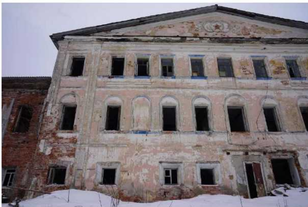
Фото 15. Фрагмент южного фасада. Общее состояние.
