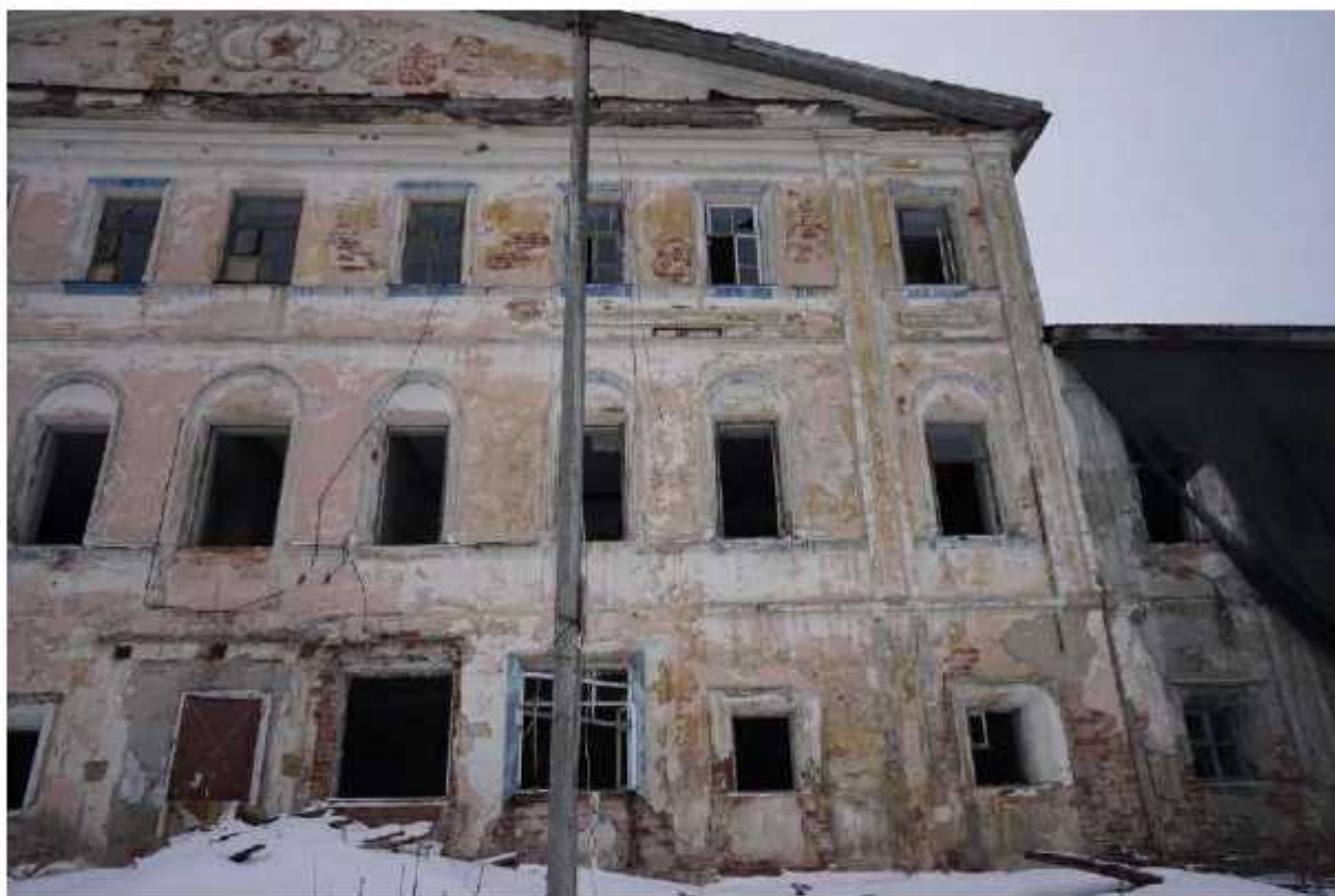
Фото 14. Фрагмент южного фасада. Общее состояние.
