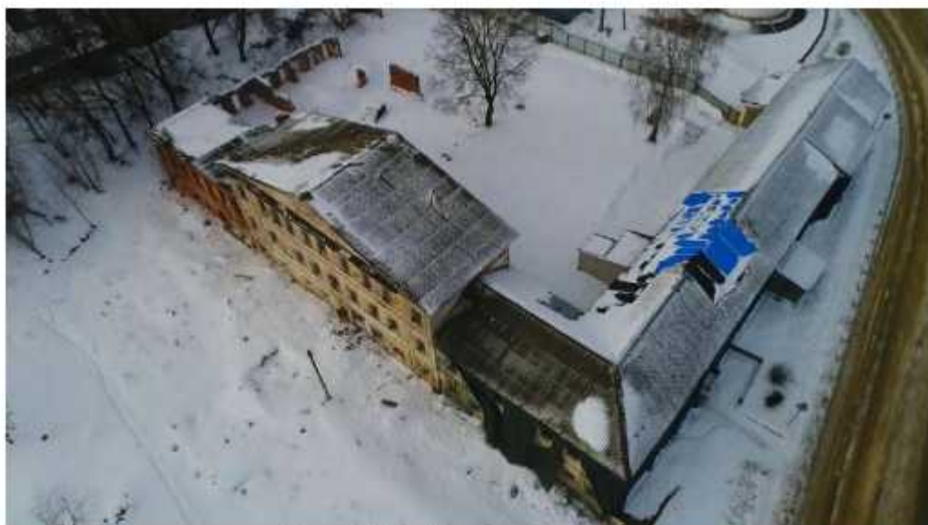
Фото №1. Общий вид сверху.
