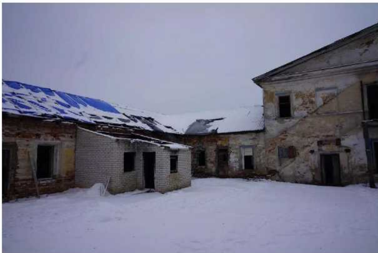
Фото 29. Фрагмент северо-западной стороны фасада восточного крыла. Общее состояние.
