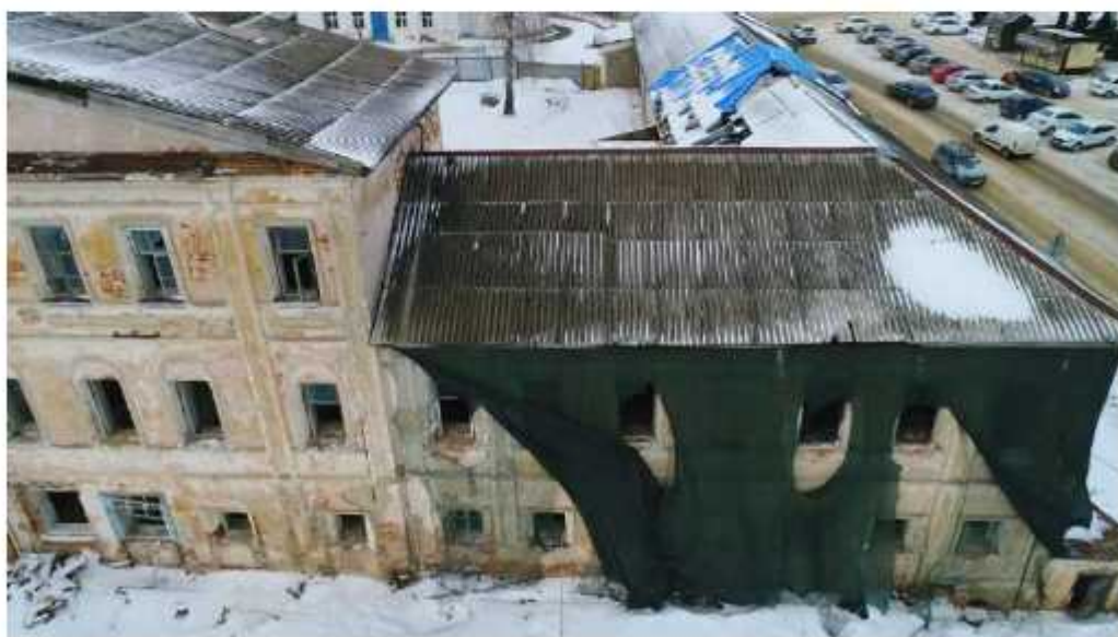
Фото 6. Фрагмент южного фасада.
