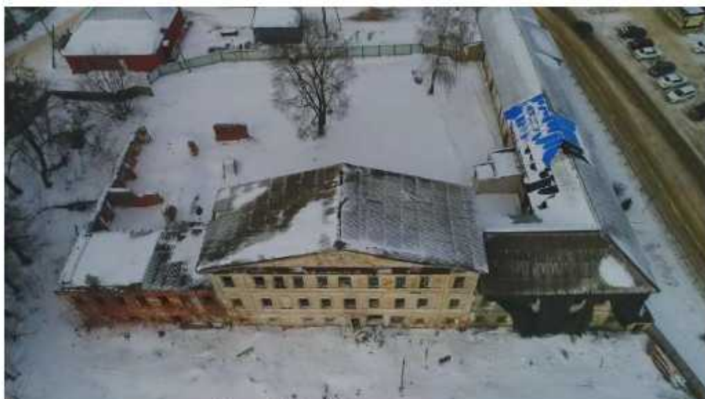
Фото №3. Общий вид сверху.
