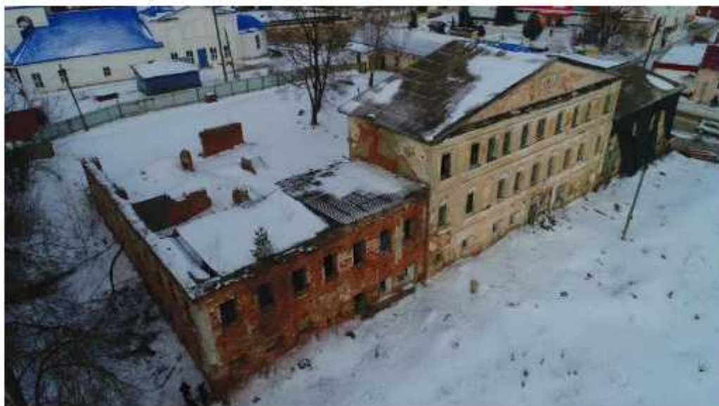
Фото 5. Южный фасад. Общий вид с юго-запада.
