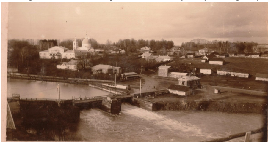
Фото 1. Вид дома в застройке левого берега р. Шани. Фото нач. XX в. из архива Районного краеведческого музея (г. Кондрово)
